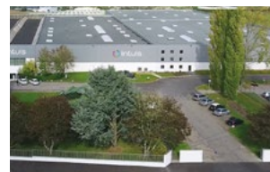
Usine de Feuquières-en-Vimeu
